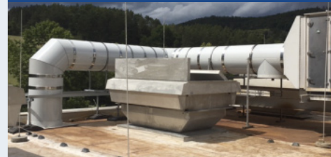
Nachher: saubere Lösung mit Luftleitungen aus PUR-Hartschaum und GFK
