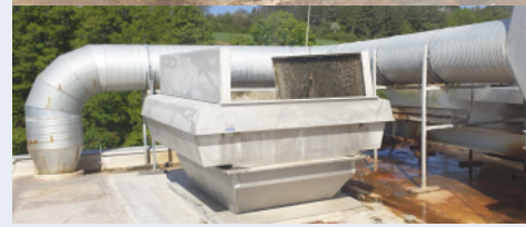
Nachher: saubere Lösung mit Luftleitungen aus PUR-Hartschaum und GFK
