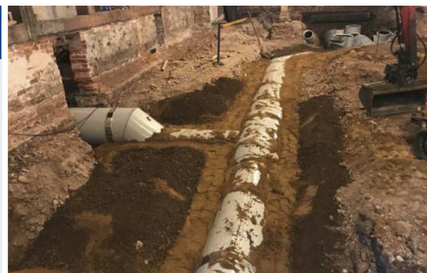
Die Gruben werden verfüllt. Bald ist von den VENTAFLEX® Leitungen nichts mehr zu sehen, der Lufttransport geschieht platzsparend und dezent im Boden.
