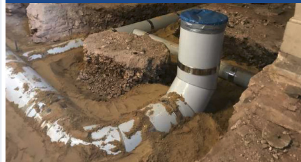
Die Gruben werden verfüllt. Bald ist von den VENTAFLEX® Leitungen nichts mehr zu sehen, der Lufttransport geschieht platzsparend und dezent im Boden.
