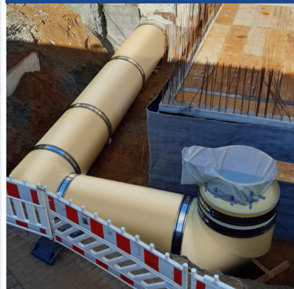
Plan und Umsetzung: innerhalb des Gebäudes wird die LAVANTUS® Luftleitung an einen Rechteckkanal angebunden, der Lüftungsturm wird später installiert.
