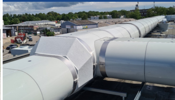
Stolz präsentieren unsere Techniker ihre „Riesenbabys“: individuell angefertigte Sonderbauteile, in diesem Fall Reduzierungen verschiedener Durchmesser
